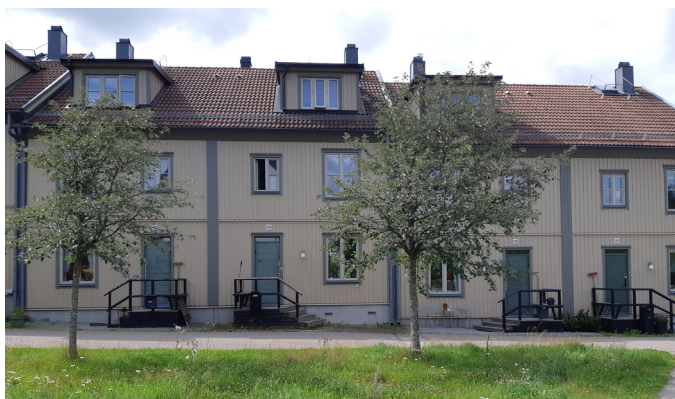
Radhus som bildar front mot gatan. Upphöjd bottenvåning med en liten trappa som minskar insyn. Tillgänglig entré från baksidan. Tullinge
