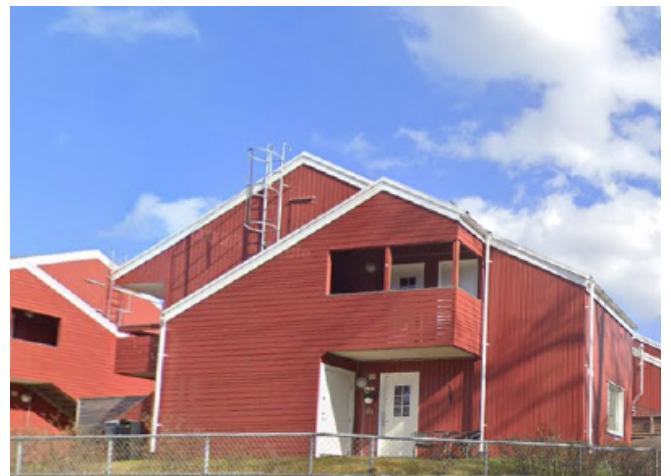
Utvändig trappa som har byggts in med träribbor och inordnats i byggnadens volym. Norrtälje
