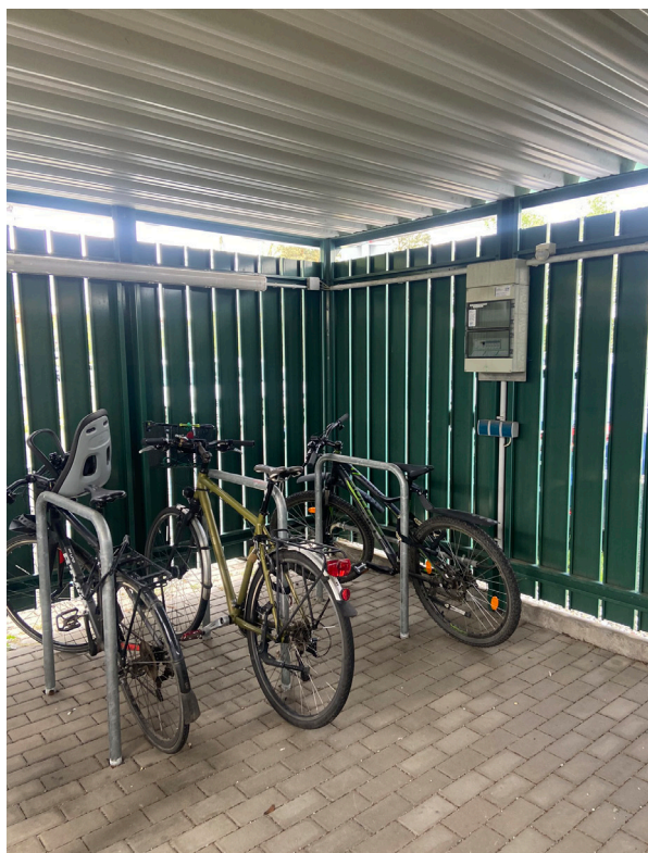
Cykelförvaring under tak med möjlighet att låsa fast ramen på cykeln och möjlighet att ladda elcyklar
