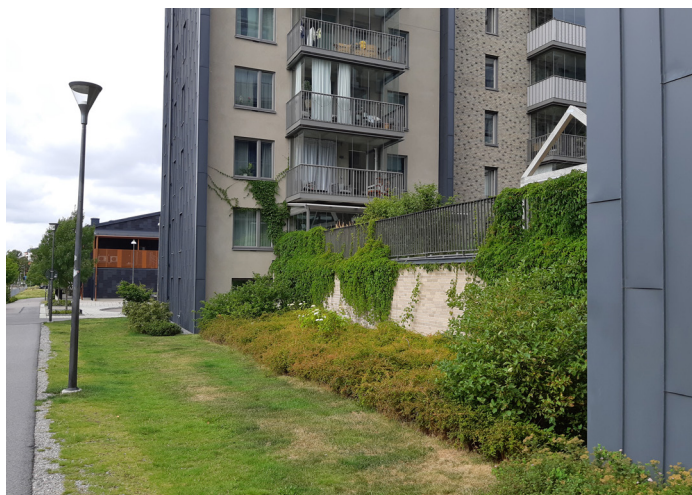
Garagevägg klädd i tegel och med växtlighet.
