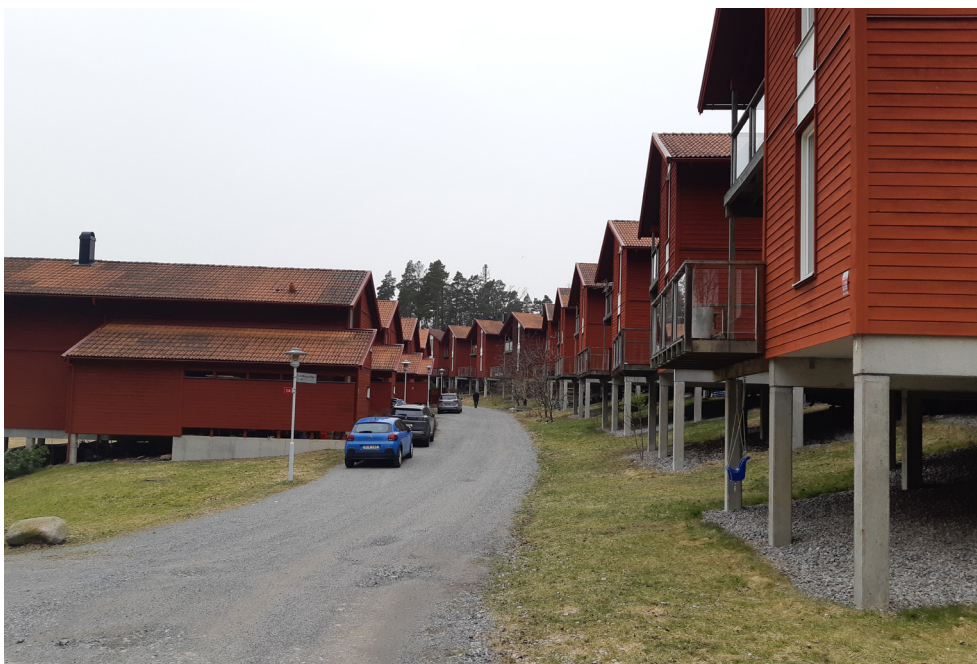
Exempel på smal angöringsgata med enkelsidig angöring. Kullön Vaxholm
